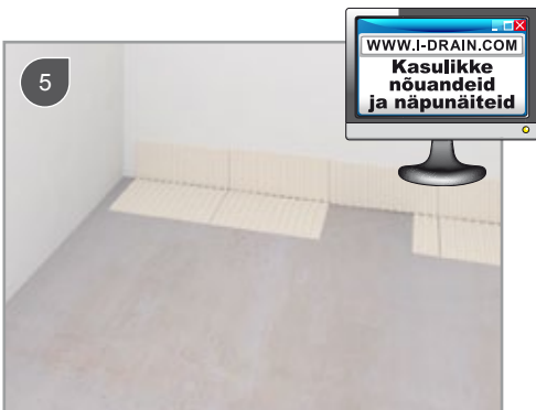
Installatsiooniploki paigaldamiseks kasuta plaatimisegu (EN 12004 C2)
