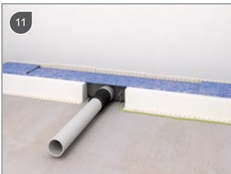
Ühenda Ø40mm äravoolutoru üleminekuga
