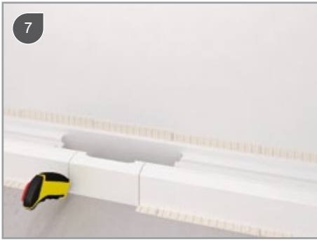
Eemalda liigne osa polüstüreeni äravoolutoru kohalt
