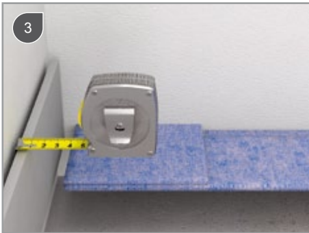
Trapi kauguse määramine seinast arvestades seinaplaadi paksusega
