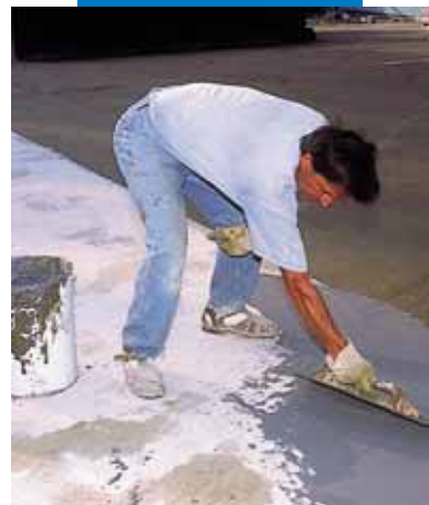
Ujumisbasseini hüdrotõkkemembraani ehitamine Mapelastic-ga
