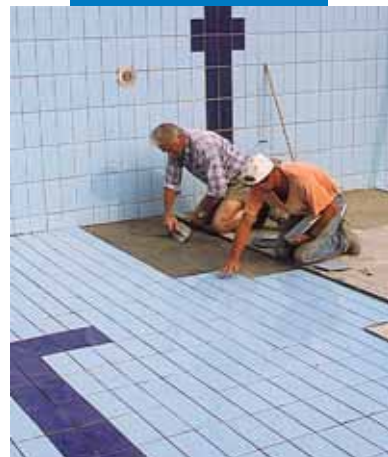
Basseini keraamiliste plaatide paigaldamine Mapelastic-le
