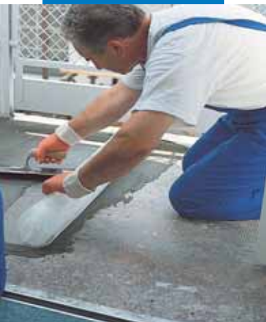
Rõdu hüdrotõkmembraani ehitamine Mapelastic-st koos klaaskiudvõrguga
