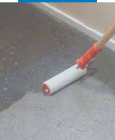
Primer G paigaldamine rulliga
