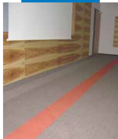
Näide Primer G paigaldamisest enne tasandussegude Ultraplan Eco ja vaibaliimi Rollcoll kasutamisest hotelliruumides - Villa Hotel Castellani - Austria
