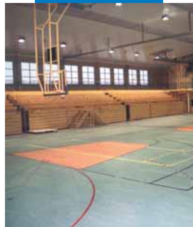
Näide Primer G kasutamisest enne PVC ja linoleumi paigaldamist spordisaali- Gdansk Orunia sisespordihall- Poola
