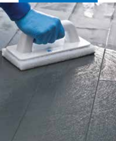
Vuukide viimistlemine Scotch-Brite® käsnaga (mört ei ole täielikult kivistunud)
