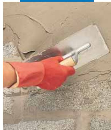
Idrosilex Pronto paigaldamine kelluga
