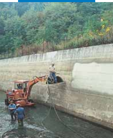
Idrosilex Pronto paigaldamine pritsiga hüdroelektrijaama kanal
