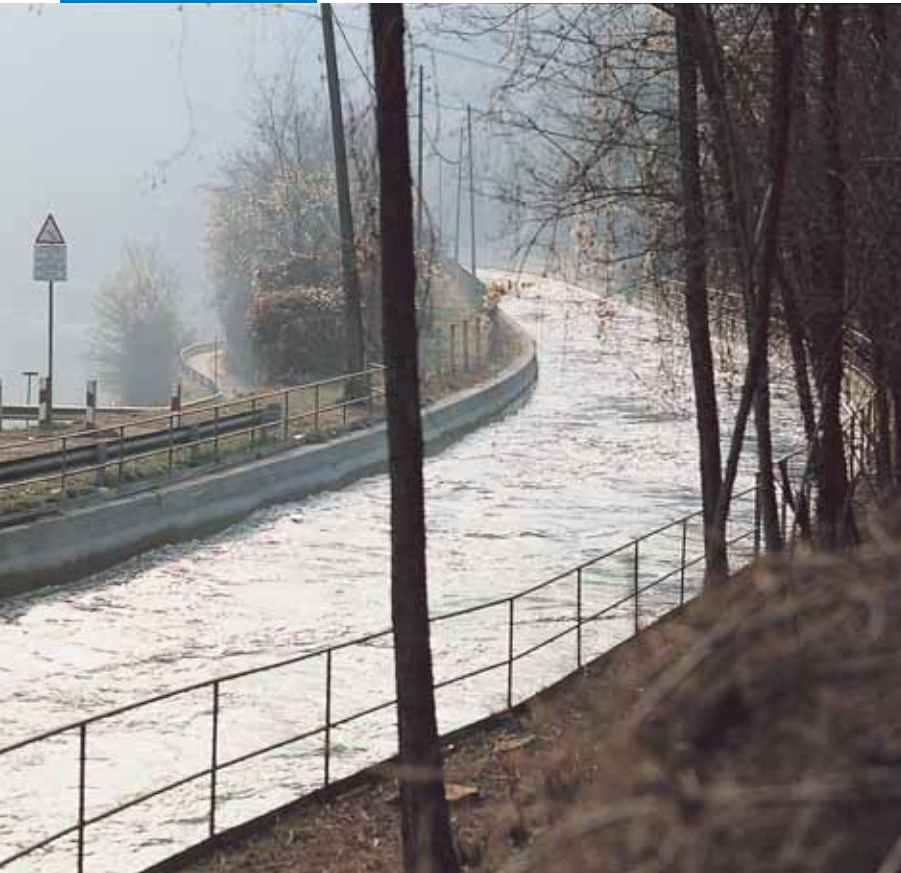
Bertini hüdroelektrijaama kanal Itaalias. Pinnad on kaetud Idrosilex Pronto
