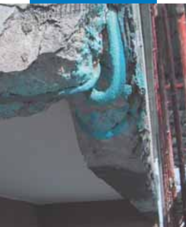
Rõduservade r/b armatuuri kaitsmine Mapefer 1K-ga
