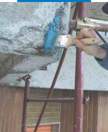
Mapefer 1K paigaldamine armatuurile pintsliga
