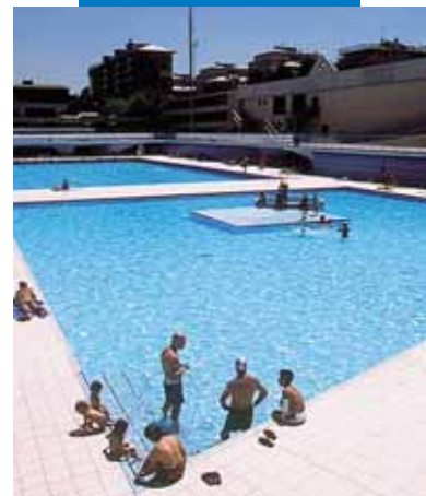
Mapelastic hüdrotõkkemembraani ga ujumisbassein: Scarioni Leisure Centre, Milano, Itaalia
