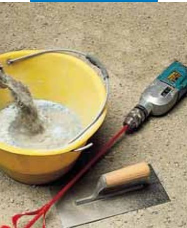
Mapelastic-u segamine mehaanilise mikseriga
