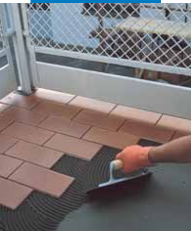
Plaatide paigaldamine plaadiliimiga Granirapid eelnevalt Mapelastic hüdrotõkmembraani ga kaitstud rõdule
