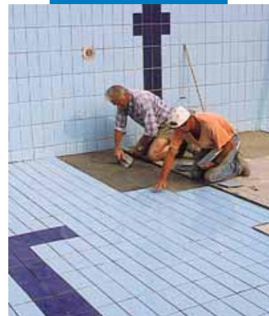
Basseini keraamiliste plaatide paigaldamine Mapelastic-le
