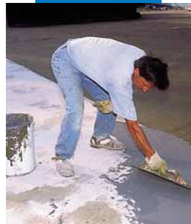
Ujumisbasseini hüdrotõkkemembraani ehitamine Mapelastic-ga
