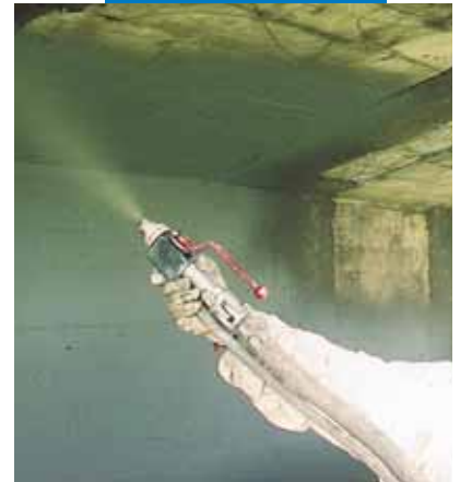
Näide Mapelastic -u paigaldamisest viaduktile pritsiga
