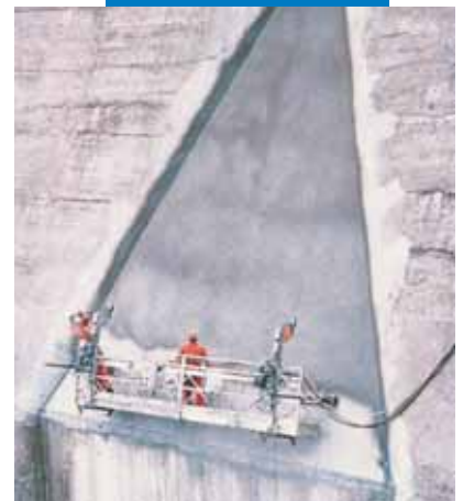
Näide Mapelastic -u paigaldamisest tammile pritsiga
