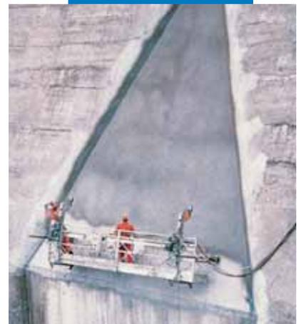
Нанесение **Mapelastic** на дамбу распылением
