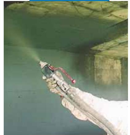
Нанесение **Mapelastic** на виадук распылением
