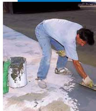
Гидроизоляция плавательного бассейна с помощью Mapelastic
