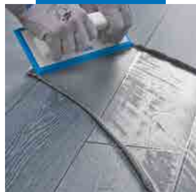
Ultracolor Plus paigaldamine põrandale kummist kelluga
