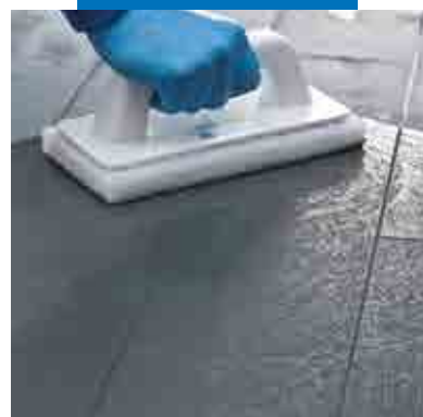
Vuukide viimistlemine Scotch-Brite® käsnaga (mört ei ole täielikult kivistunud)
