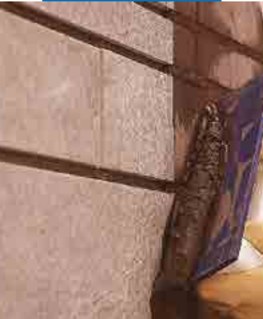
Ultracolor Plus paigaldamine seinale kummist kelluga
