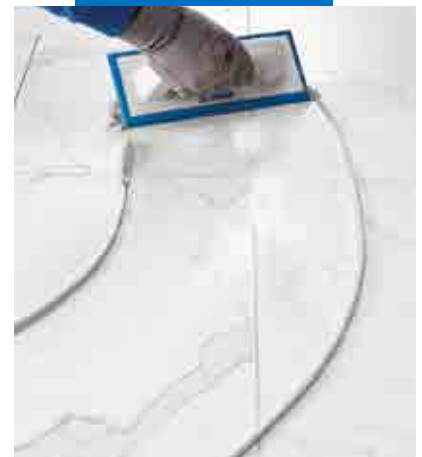
Ultracolor Plus paigaldamine põrandale kummist kelluga
