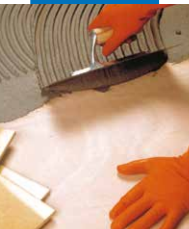
Portselanplaatide paigaldamine veekindlale vineerile Elastorapidi liimiga
