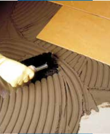
Elastorapidi paigaldamine tsementmördile segukammiga
