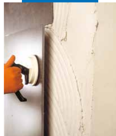
Suurte portselan- plaatide paigaldamine betoonfassaadile Elastorapidi liimiga
