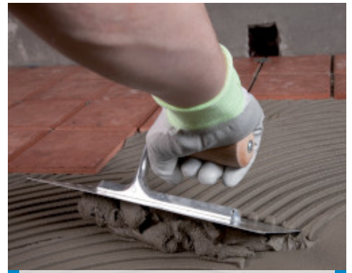
Granirapid toote paigaldamine Mapelastic hüdroisolatsiooniga terrassile
