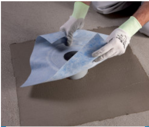
Äravoolutrapi paigaldamine Mapelasticu abil
