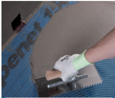
Mapelasticu paigaldamine Mapenet 150ga
