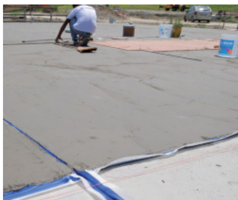
Hüdroisolatsioon Mapelastic ja Mapeband toodetega
