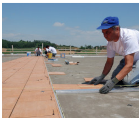
Keraamika paigaldamine: Kerabond + Isolastic
