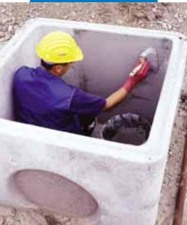
Пример гидроизоляции шахты люка с помощью кисти
