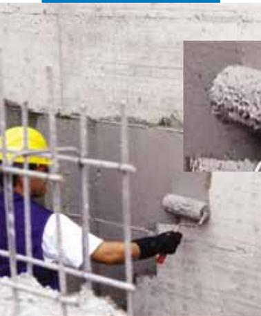
Пример гидроизоляции фундамента с помощью валика
