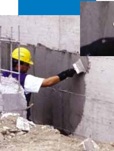
Пример гидроизоляции фундамента с помощью кисти
