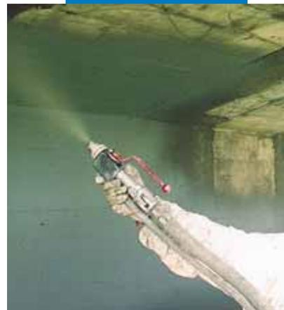
Нанесение **Mapelastic** на виадук распылением
